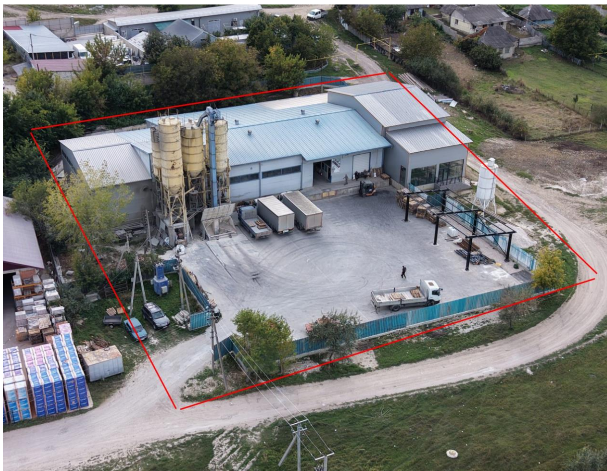
Foto 1. Vedere aeriană (dronă). Cu linie roșie – perimetrul utilizat: secție de producere a mortarelor uscate cu silozuri, depozite, transport. Activitatea este desfășurată de GENERAL BUILDING [D18].
