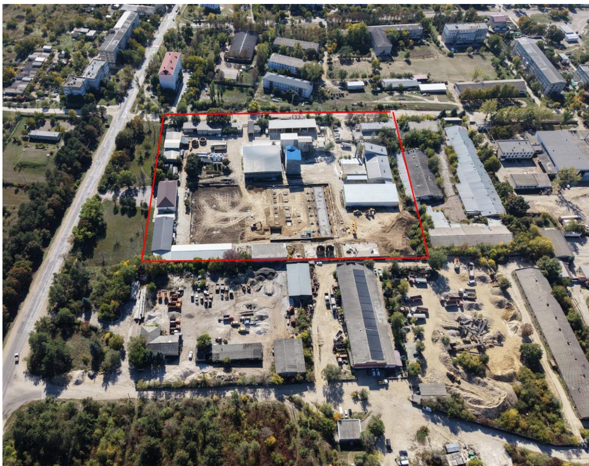
Foto 3. Vedere aeriană (dronă). Cu linie roșie – platforma 4501212.180: hale noi, instalații, șantier activ [D18].
